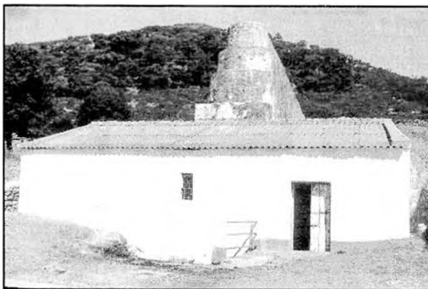
Exterior del molino de Juan Gil, situado en la Garganta del Rayo. En la parte superior la tajea o torre que canaliza el agua que mueve la rueda del molino. (Foto: Francisco Ruiz León)
