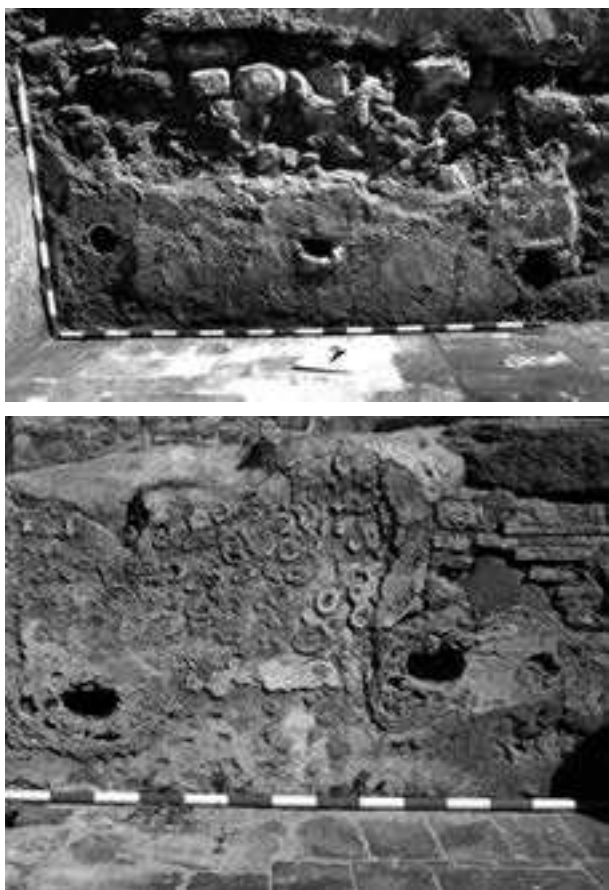
Figura 10 a y b. Muros laterales en la cabecera de la capilla, con orificios en pendiente (Alejandro Pérez-Malumbres Landa).
