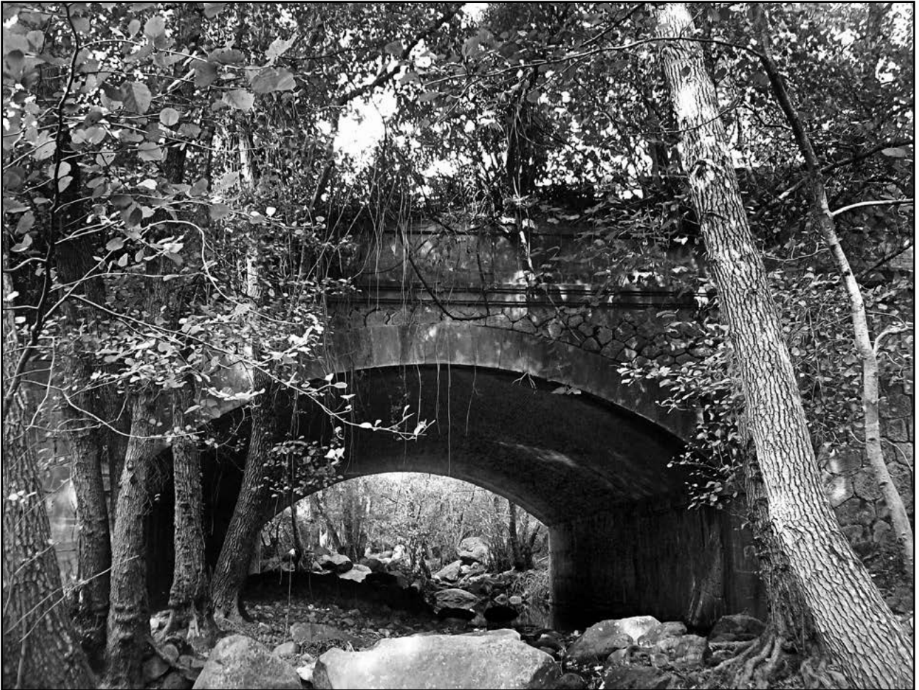
Figura 3. Puente de Guadalmesi. Fue proyectado en 1863 por el ingeniero J. Ravina, con seis metros de ancho. En el siglo XX se le adosó uno de hormigón de 16 metros. Foto autor.
