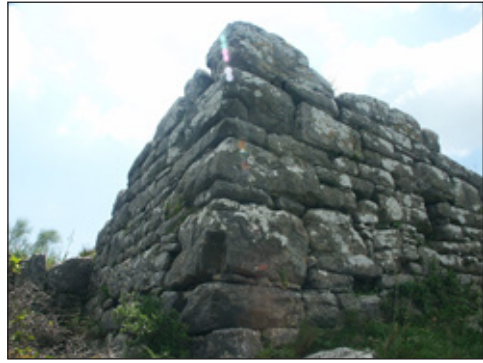
Figura 3.- Bastión Oeste de Lacipo (Casares, Málaga).
