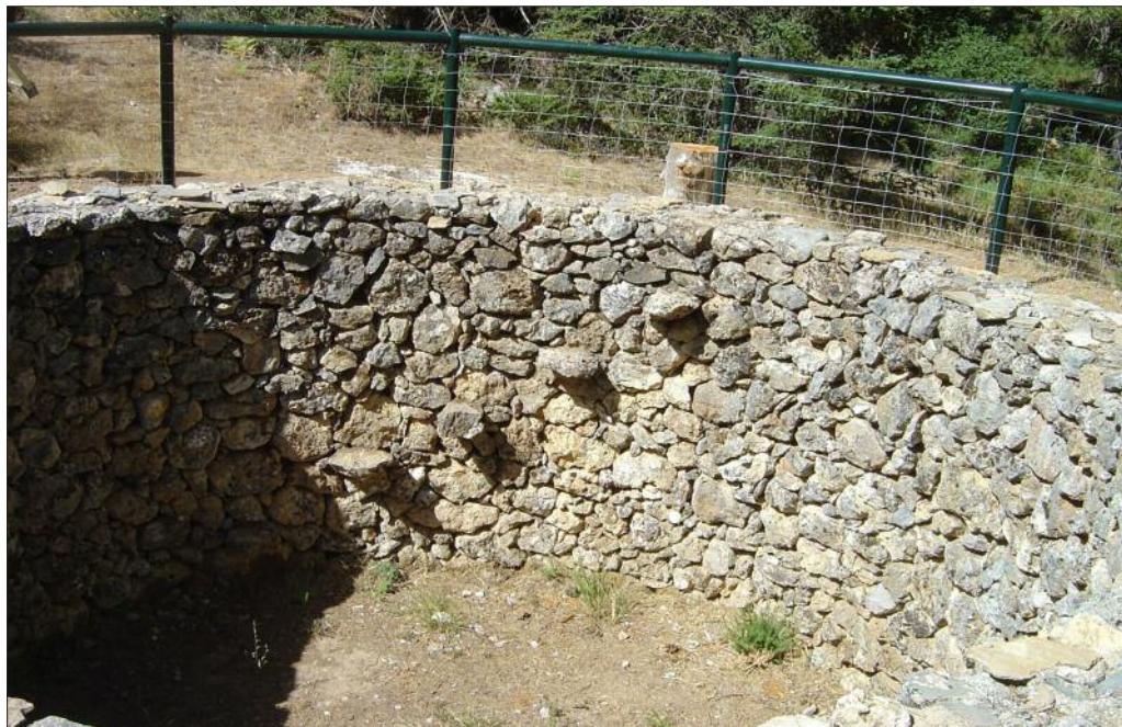
Figura 2.-Interior mismo pozo de nieve. Obsérvese el detalle de los escalones de piedra. Foto autor.
